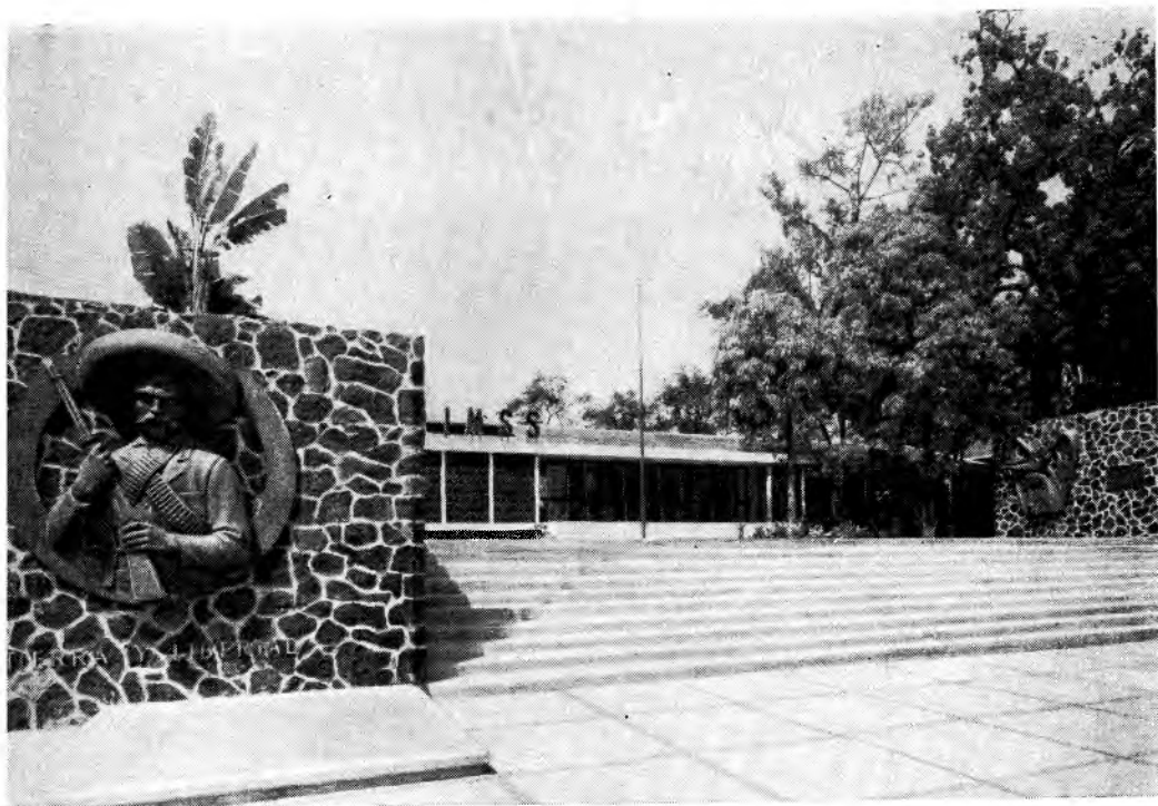
Здание социального обеспечения в штате Морелос. 1964 г. Архитектор Алехандро Прието
