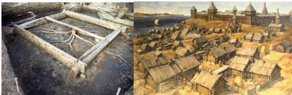
Рис. 9. Строительство дома на корневой системе дерева (фото НПО «Северная археология-1»). Видно, что при строительстве использовались куски корабельного кия; Мангазея (реконструкция).
