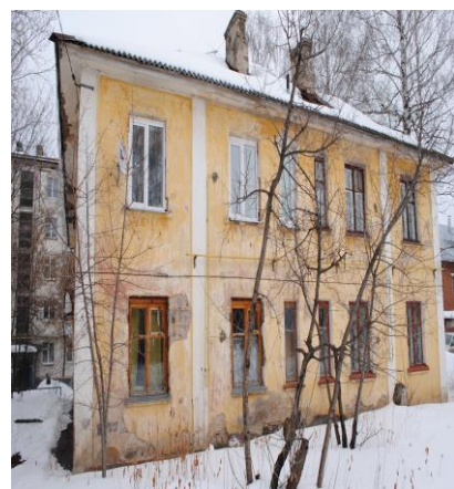
отклонение стен от вертикали
