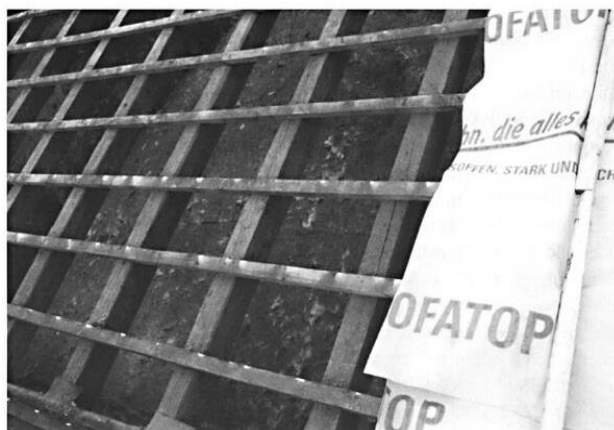
Вскрытие кровельного покрытия и обрешеток при обследовании настилов
