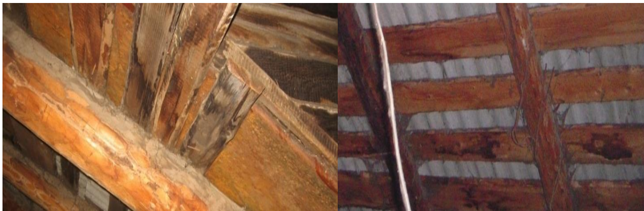
Рис. 2.21. Обследование деревянных крыш: наклонные стропила, прогоны
