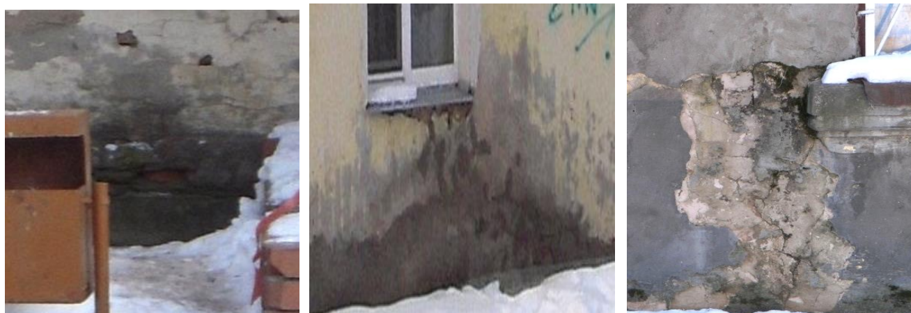
Рис. 2.16. Обследование цоколя и отмостки с целью определения физического износа фундаментов
