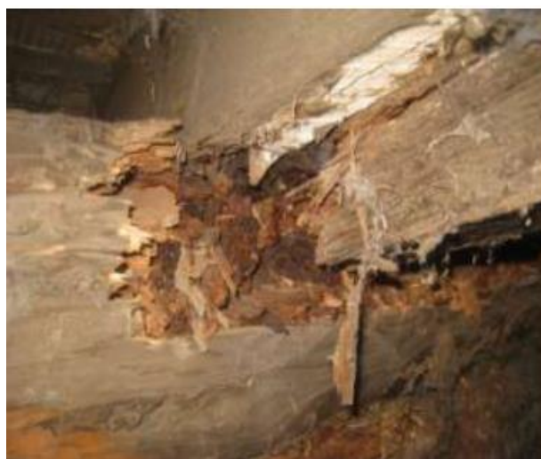
Рис. 2.33. Разрушение гнилью опорной части стропильной ноги и мауэрлата
