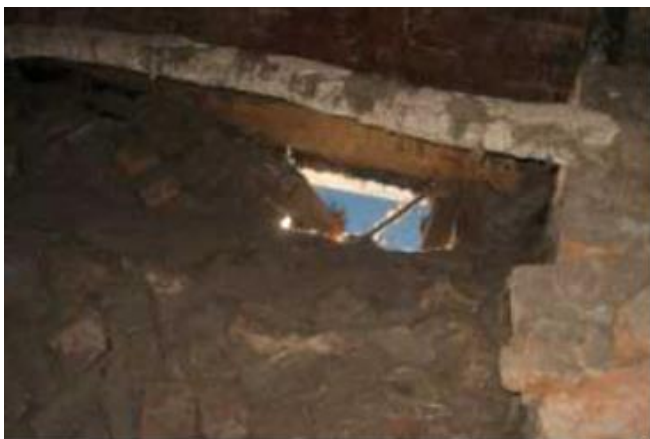
Рис. 2. 28. Частичное разрушение дощатой подшивки, обрушение потолка
