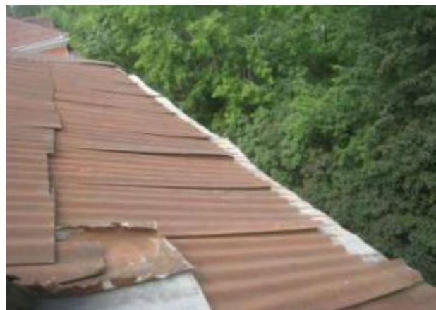
Рис. 2. 29. Коррозия металлической кровли, свищи, пробоины, нарушение и частичное отсутствие креплений листов.
