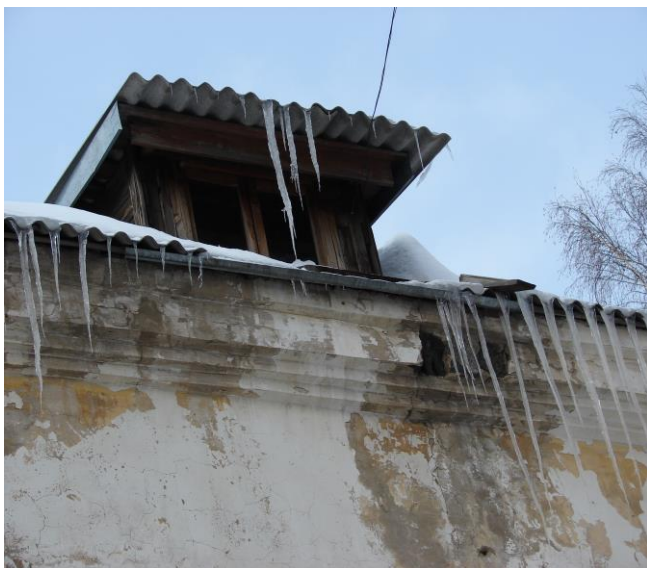
Рис. 2. 27. Состояние заполнений оконных проемов и слуховых окон
