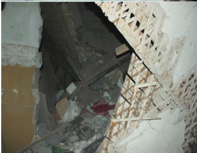
Обрушение перекрытия жилого дома в г. Киров после перепланировки квартиры первого этажа под магазин
