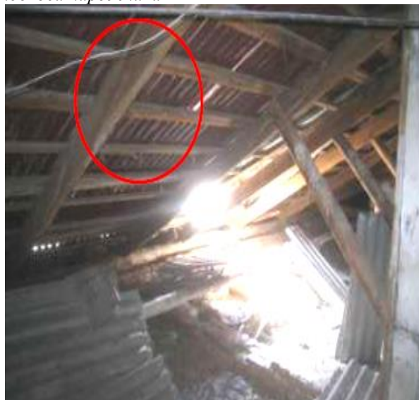
Рис. 2.32. Отсутствие подкоса нарожника
