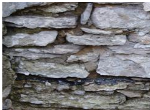
Фотографии внешней стороны кладки бутовых фундаментов со следами физического износа и снижением прочностных свойств.
