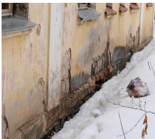
намокание цоколя стен, отсутствие отмостки
