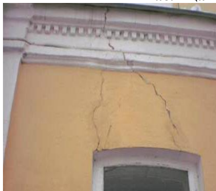
расслоение и выпучивание кладки
