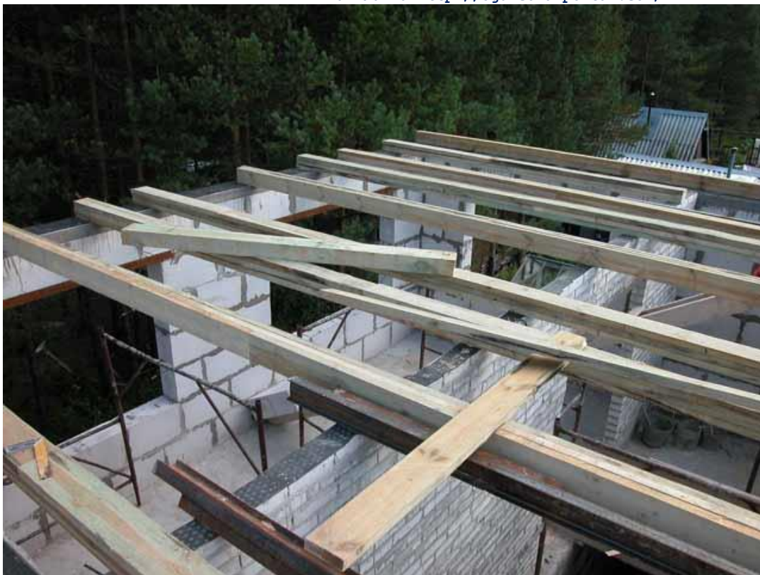
Подготовка к выполнению перекрестного перекрытия
