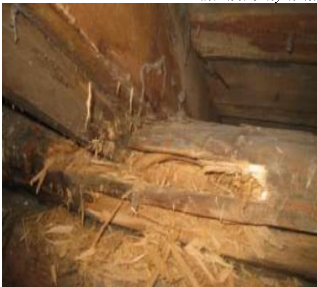
Рис. 2.31. Разрушение гнилью опорной части стропильной ноги и мауэрлата
