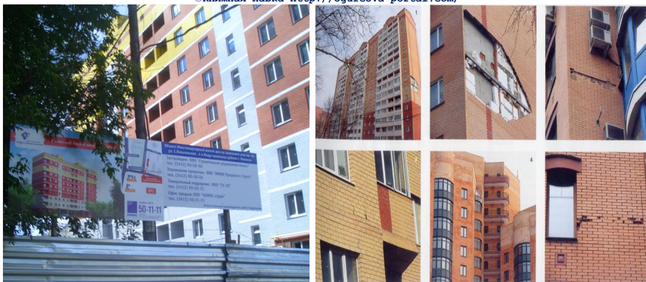
Рис. 2.15. Монолитный жилой дом по ул. Софьи Ковалевской в г. Ижевске (слева) сданный в эксплуатацию в 2011 году, вступит в период интенсивного физического износа в 2021 году. К концу периода нормальной эксплуатации его ограждение будет осыпаться таким же образом, как это можно наблюдать на московских высотках (справа), возведенных в середине «нулевых» годов.
