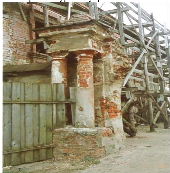
Реконструкция кирпичных колонн с гипсовой лепниной
