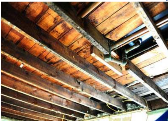
Рис. 2. 26. Вид деревянных перекрытий, вскрытых снизу
