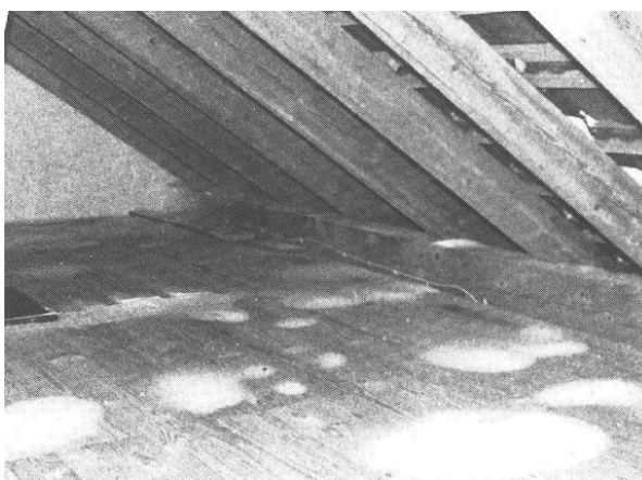
Опираение наслонных стропил на мауерлат
