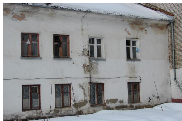
Рис. 2.3. Строительство монолитного жилого дома «точечной застройкой» в массиве жилья III группы капитальности в г. Ижевске по ул. Софьи Ковалевской – привело к резкому снижению несущей способности фундаментов: сразу после сдачи соседнего сооружения в эксплуатацию вертикальная трещина посреди здания достигла карнизной кладки еще в период отопительного сезона, до оттаивания оснований
