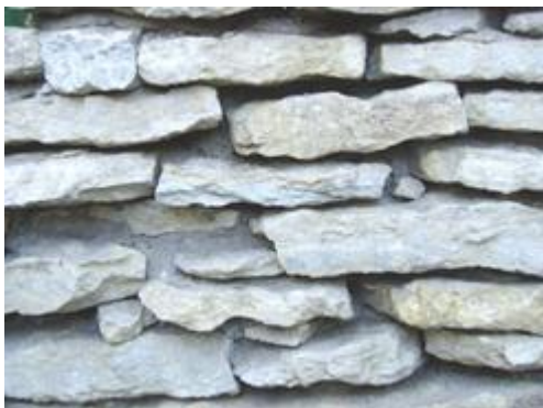
Фотографии внешней стороны кладки бутовых фундаментов со следами физического износа и снижением прочностных свойств.
