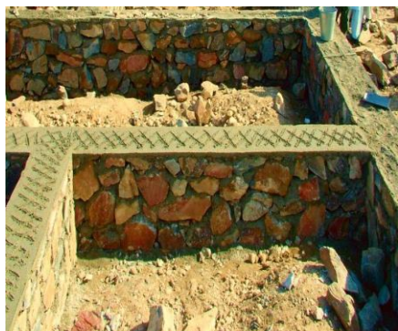
Общий вид бутобетонного фундамента
