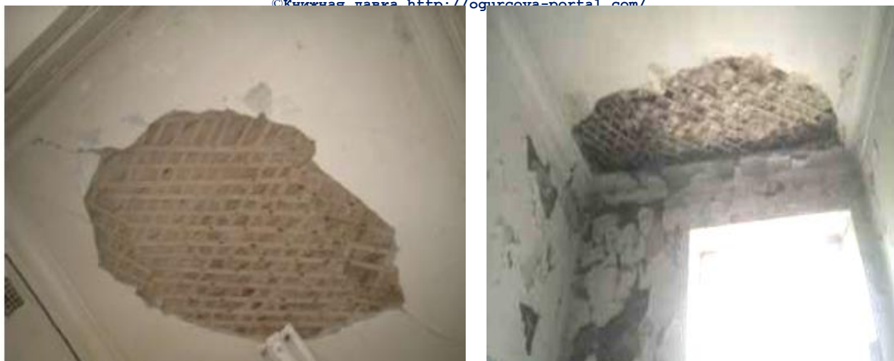
Рис. 2.25. Разрушение штукатурки потолка второго этажа из-за протечек крыши. В этом месте должны быть проведены дополнительные вскрытия.
