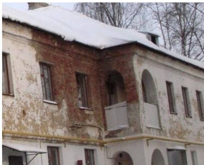
Рис. 2.17. Наружные стены из облегченной кладки
