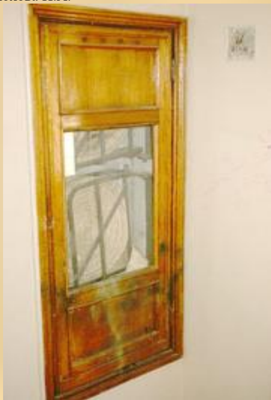
Окошко пожарного гидранта с рамой из мореного дуба и фигурного дымчатого стекла, которое необходимо разбивать при пожаре
