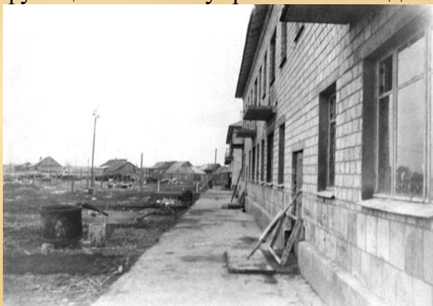
Внутренний дворик домов с неогражденными, но уже разопалубленными балконными плитами второго этажа. Стены из силикатного кирпича высокотехнологичного обжига, не нуждающегося в защитном слое штукатурки
