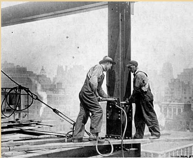
Рабочие затягивают болты базы колонны. Рабочий слева стоит на доске, выдвинутой над пропастью. 1930 г.
