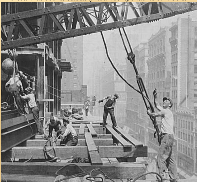
Гуськовые краны установлены на центральном каркасе из колонных двутавров – начинается монтаж пристроев.
