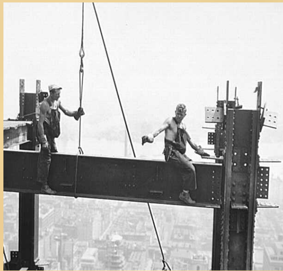
Небоскребы Нью-Йорка. Соединение узла оголовка на болтах. 1930 г.
