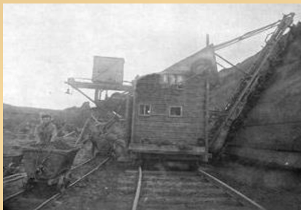
Фрезерный экскаватор на производстве кирпича. Рабочий поселок Уктус Свердловской обл. 1947 г.
