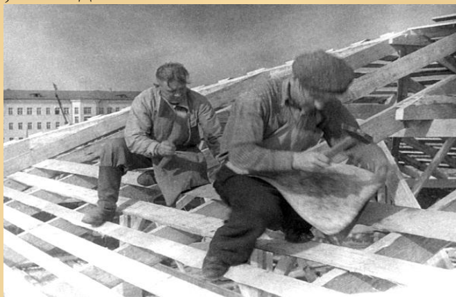
Устройство обрешетки по наклонным стропилам крыши
