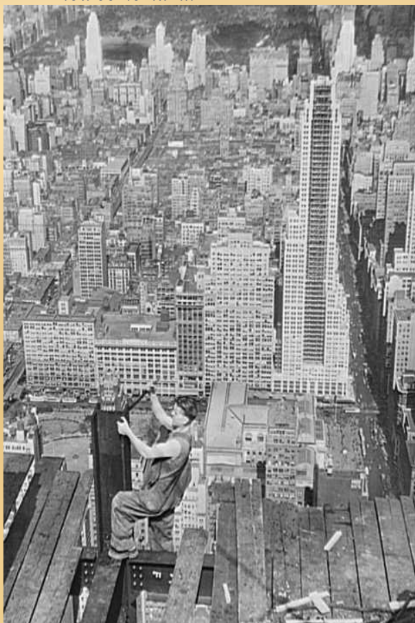
Затягивание болтов накладок на полки колонны для последующего монтажа. Нью-Йорк. 1930 г.
