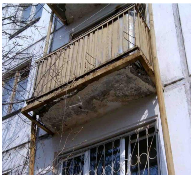
Балконные плиты жилого крупнопанельного здания застройки 60-х годов
