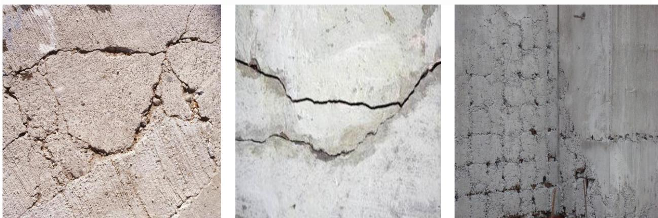
Трещины выявляются путем осмотра открытых поверхностей конструктивных элементов перекрытий и узлов их соединения (поперечных и продольных балок, полок плит).
