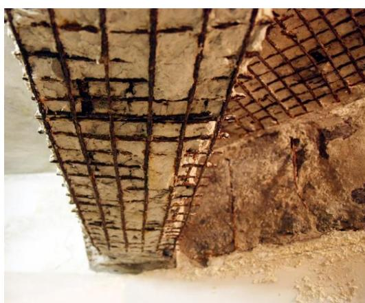
Рис. 3.23. Поперечная арматура у опор
