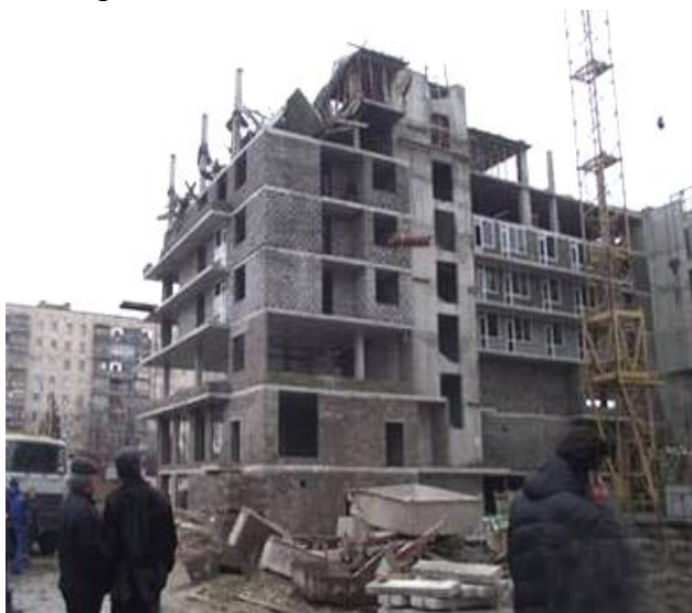
Рис. 1. 4. Обрушение монолитного перекрытия седьмого этажа строящегося жилого дома в г. Белгород
