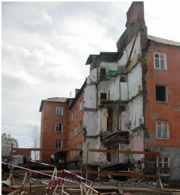
23 августа 2011 г. во Владивостоке после ливня произошло частичное обрушение конструкций жилого дома по адресу улица Посьетская, 28. Перед обрушением длительное время развивались трещины из-за явлений просадочности оснований и работ, проведенных в подвале дома владельцем цокольных помещений.
