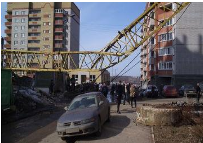
07.04.2010 г. в Кирове на улице Ленина, 189 гусеничный кран упал на жилой дом, повредив остекление двух лоджий и кирпичную кладку одного балкона. Пострадал крановщик
