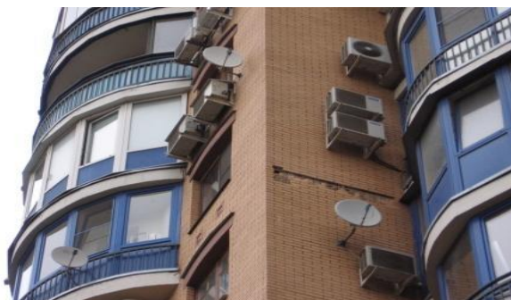
Разрушение кирпичной облицовки эркеров и углов жилого дома с монолитным каркасом
