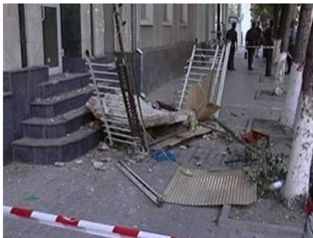
20.06.2011 г. произошло обрушение трех балконов пятиэтажного жилого дома в Якутске. В жилом доме отключен газ, частично электроэнергия. Начаты работы по разбору завалов.
