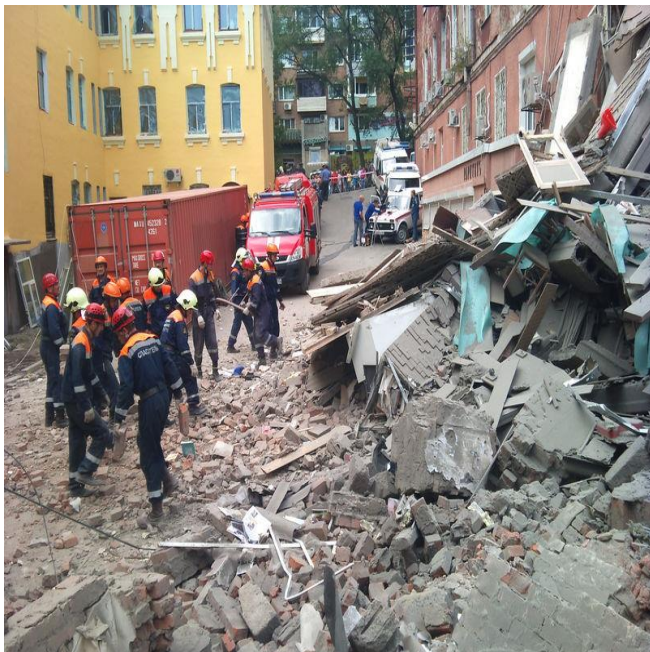
23 августа 2011 г. во Владивостоке после ливня произошло частичное обрушение конструкций жилого дома по адресу улица Посьетская, 28. Перед обрушением длительное время развивались трещины из-за явлений просадочности оснований и работ, проведенных в подвале дома владельцем цокольных помещений.
