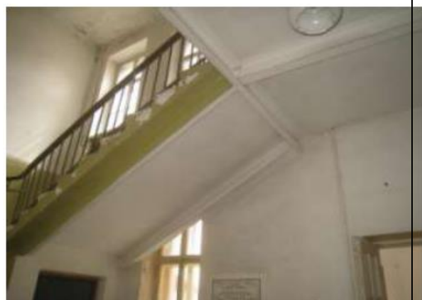
Вид металлических косоуров лестничного марша между 1-м и 2-м этажами в осях В-Г/4-2
