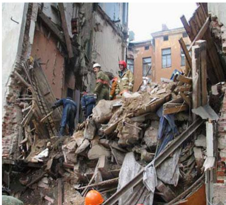
09 октября 2006 г. около 04:00 мск. на Железнодорожной улице в городе Выборге Ленинградской области обрушился подъезд 4-этажного жилого дома. В результате трагедии семь человек погибли и 19 человек пострадали. Основной причиной происшествия считается несанкционированная перепланировка одной из квартир
