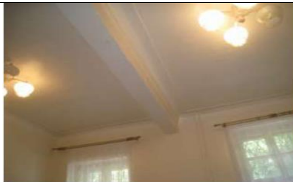
Монолитная железобетонная балка перекрытия над 1-м этажом в осях Г-В/5
