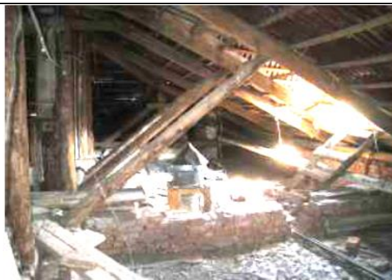
Вид деревянных конструкций покрытия в осях В-Г/4-1: стропильные ноги, подкосы
