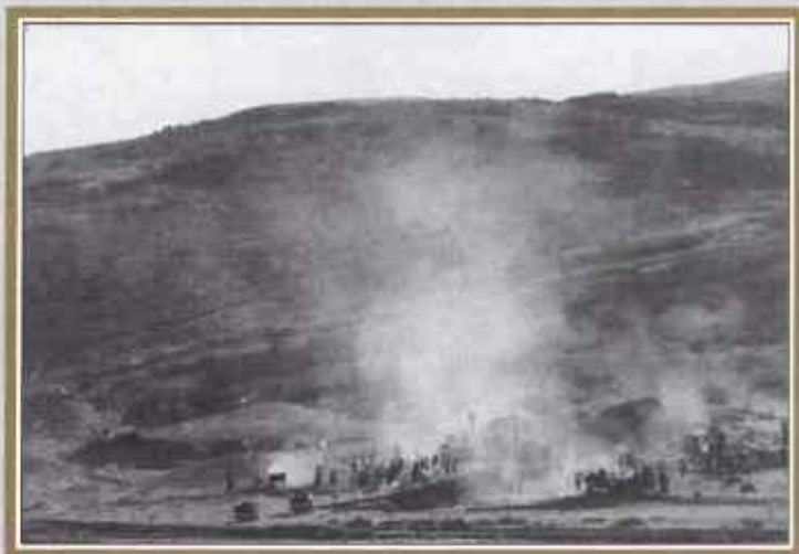
Вверху: над Горой Удачи клубится пыль — землекопы откапывают восточные укрепления. Для отправки земли на место свалки используются тележки.
