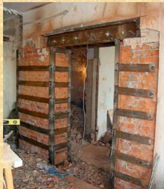
Усиление кирпичных перемычек: а - расклинивание трещин стальными пластинами; б, в - стальными уголками при небольшом (б) и длинном (в) пролетах; г - стальными уголками, соединенными со стальной обоймой простенков; 1 - кирпичная стена; 2 - трещина; 3 - перемычка; 4 - стальные пластины-клинья; 5 - стальной уголок; б - тяжи из полосовой стали; 7 - стальная обойма простенка
